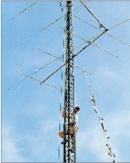
Errichten der 80-m-Antenne von V47KEP auf St. Kitts
